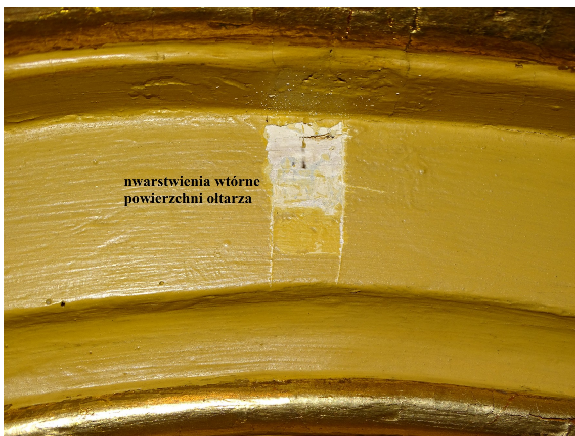
Fot. 27 Odkrywka nr 6 Nawarstwienia wtórne w arkadach bramek obejścia ołtarza głównego.
