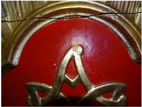
Fot. 18,19 Uszkodzenia i zniszczenia ołtarza; pęknięcia, złuszczenia, odspojenia gruntu, uszkodzenia mechaniczne,
