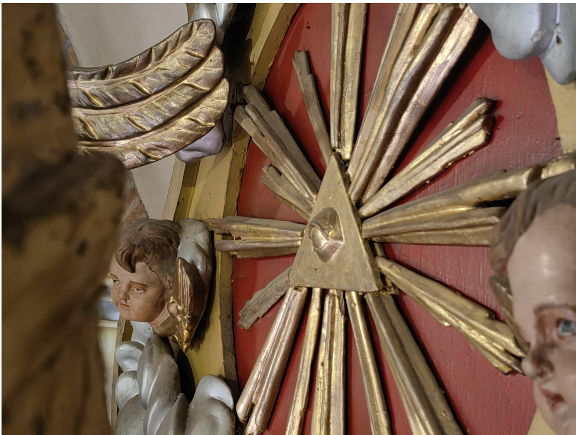
Fot. 16 Zniszczona i zaoksydowana pozłota glorii z okiem opatrności
