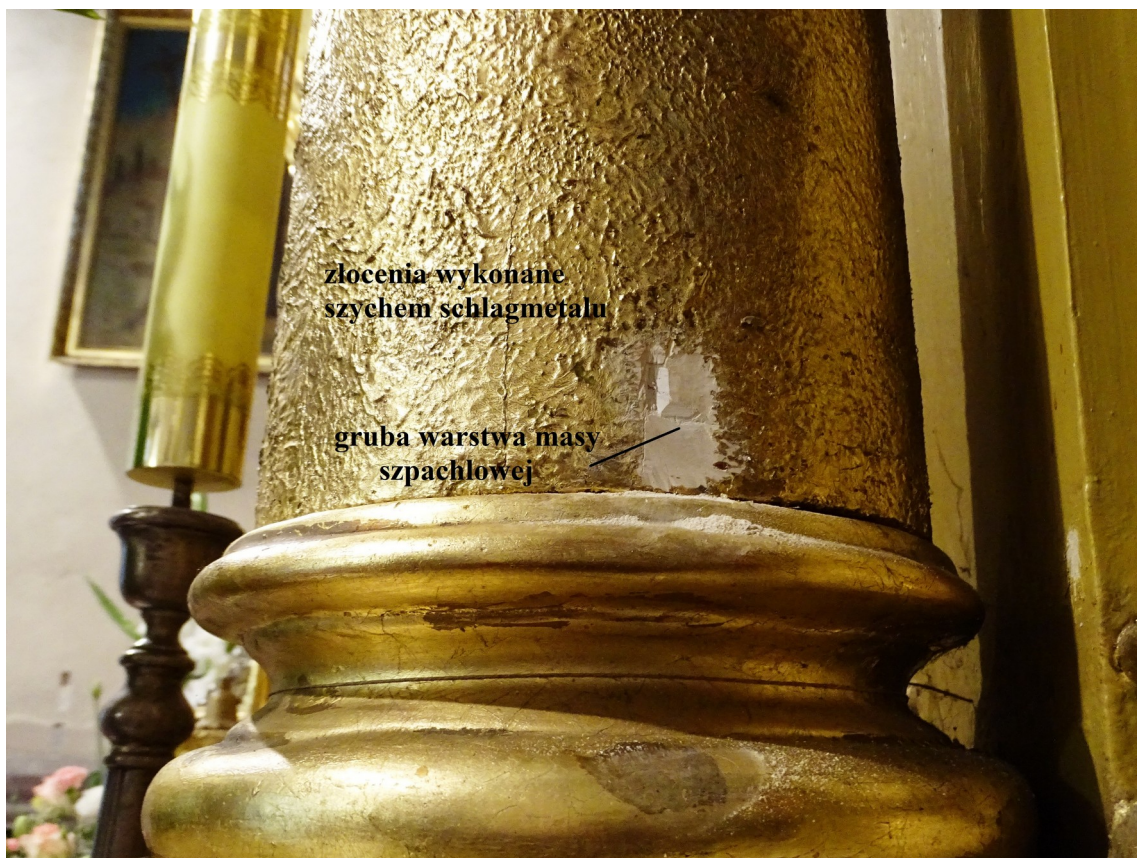
Fot. 26 Odkrywka nr 5 Warstwy kolumny ołtarza głównego.
