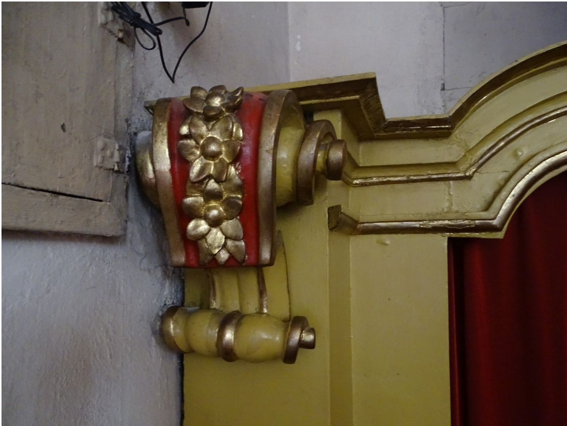
Fot. 3 Zaoksydowane pozłoty oraz ślady po wcześniejszych naprawach
