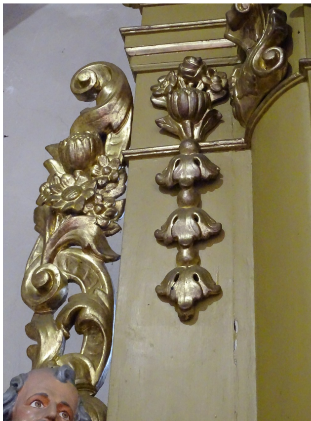
Fot.7 Uszkodzenia i pęknięcia konstrukcyjne ołtarza oraz zaoksydowane elementy dekoracji
