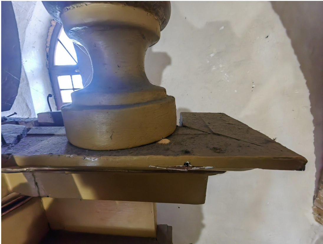
Fot.13 Warstwa kurzu i brudu na gzymsie oraz uszkodzenia mechaniczne i ślady po żerujących owadach
