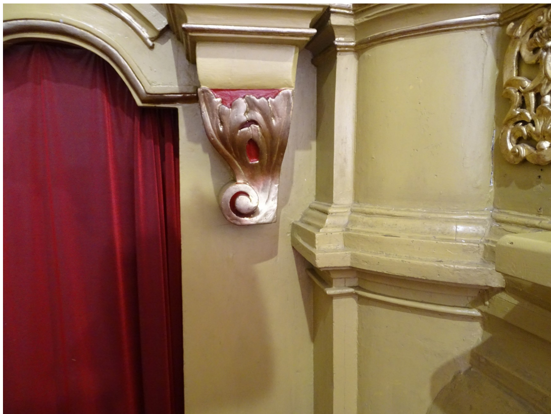
Fot. 5 Zabrudzenia i uszkodzenia ołtarza
