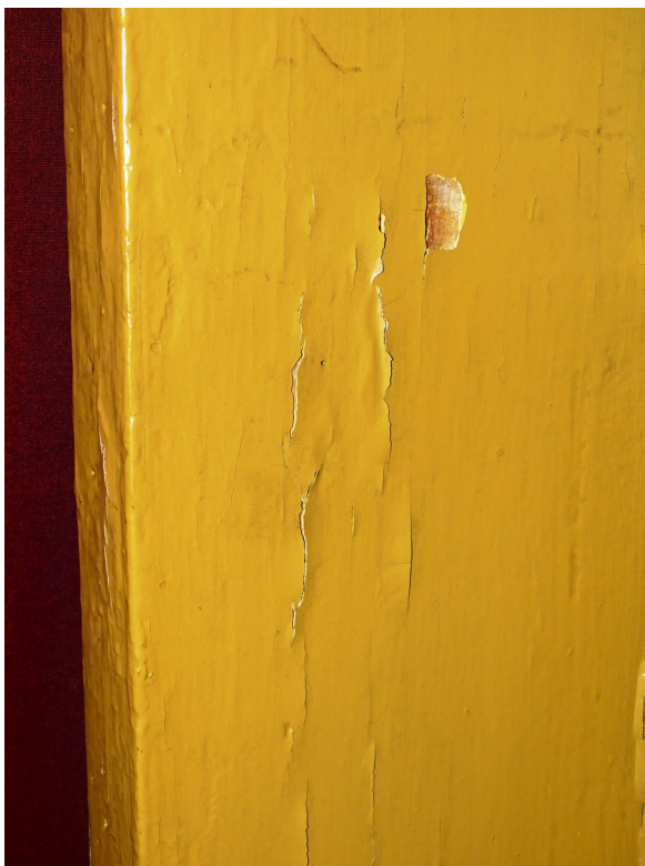
Fot. 20,21 Złuszczenia i odspojenia gruntu na bramkach obejścia ołtarza spowodowane prawdopodobnie nadmierną wilgotnością
